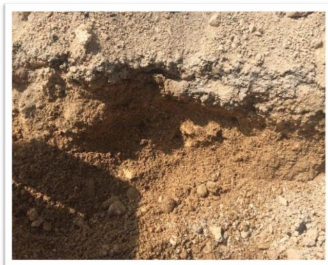
شکل ۳- نیمرخ روسازی برداشته شده در سطح شهر یاسوج
