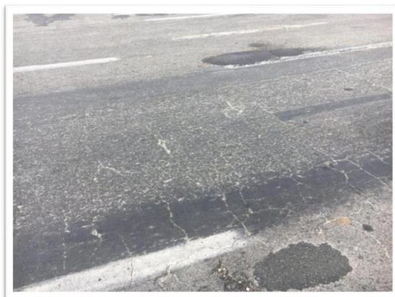
شکل ۲- ترک های پوست سوسماری
