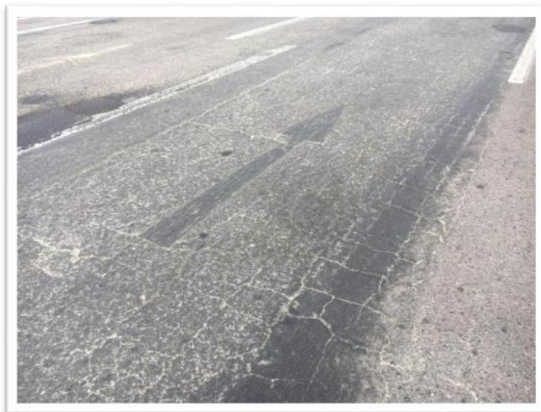
شکل ۱- ترک های پوست سوسماری
