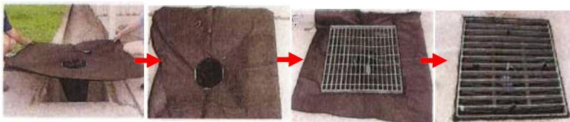
شکل ۱. رویکرد نصب فیلتر محافظ زهکشی
